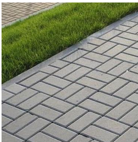
Sposób ułożenia kostki betonowej
